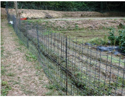
出来あがった防護柵
