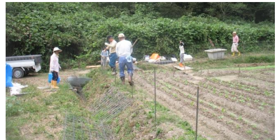
支柱の打ち込み最終段階。一周してきました100本目
