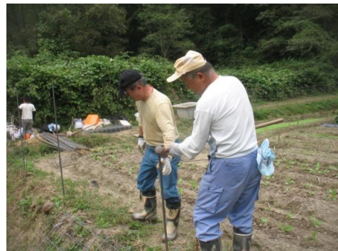
間隔を決めて支柱の打ち込み
