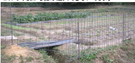
徹の網が取り付けられて防護柵が出来あがりました。
