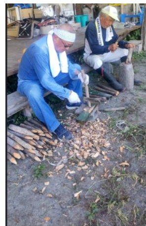
階段修理のための杭づくり
