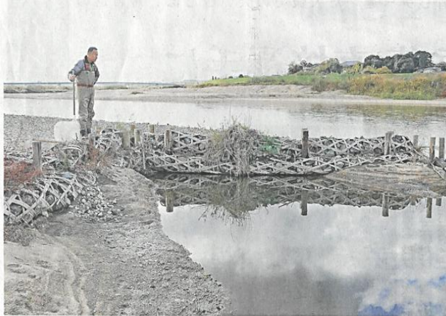
伝統河川工法の応用で昨年から新たに作っている湾処。小魚やエビ、水生昆虫が生息している(井手町井手の木津川)
