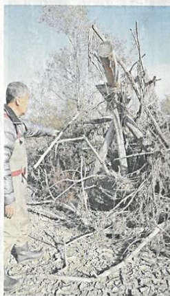
2017年に設置した中聖牛。洪水時に流れてきた植物が根付いて一体化した(野坂真輝)
