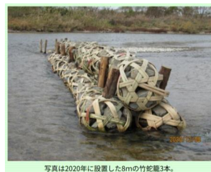
写真は2020年に設置した8mの竹蛇籠3本。
